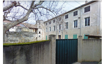
Ilôt 32. Parcelle 965. Partiellement abandonnée
