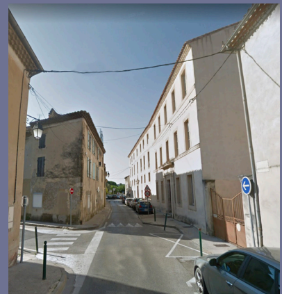
Immeuble 19ème siècle. Ilôt 34 Angle de la Rue Michelet et D976
