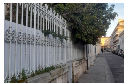
Traitement des grilles
