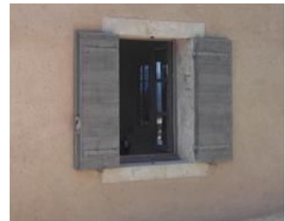
Exemple de badigeon en encadrement de fenêtre
