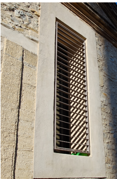
Exemple de locaux techniques intégrés dans une fenêtre d'une boutique.
