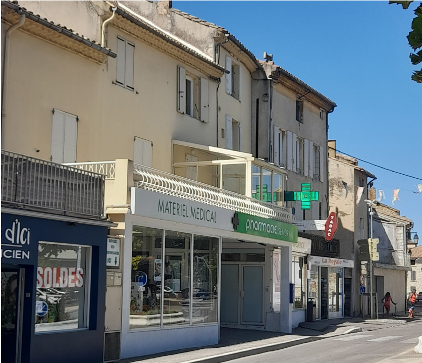
Pas d'harmonie recherchée entre les devantures et implantations sous balcons dommageables
