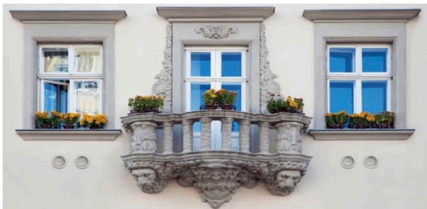
Exemple de sortie d'air conditionné camouflé dans la modénature
