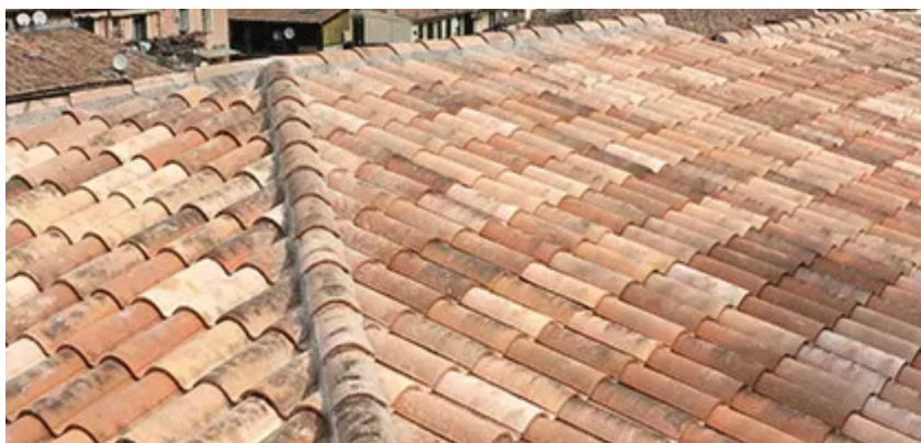
Panachage de teintes, avec l'utilisation de tuiles neuves et de récupération
