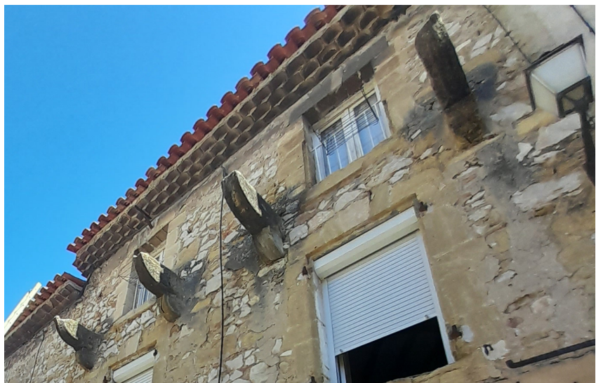
Supports d'encorbellement sur la Rue Clément V
