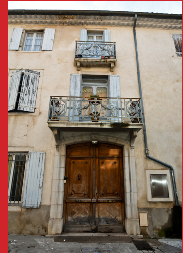
Positionnement des descentes d'eau pluviale en façade, au droit des mitoyens
