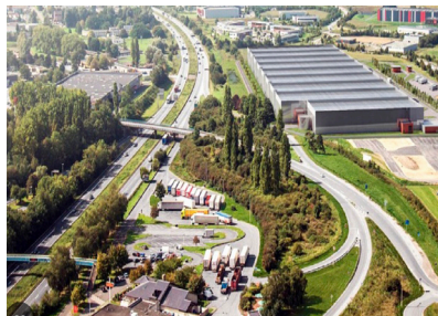
Exemple d'implantation d'un entrepôt aux abords du réseau autoroutier
