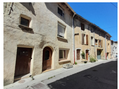
Exemple de rangs d'immeubles dans le centre-ville
