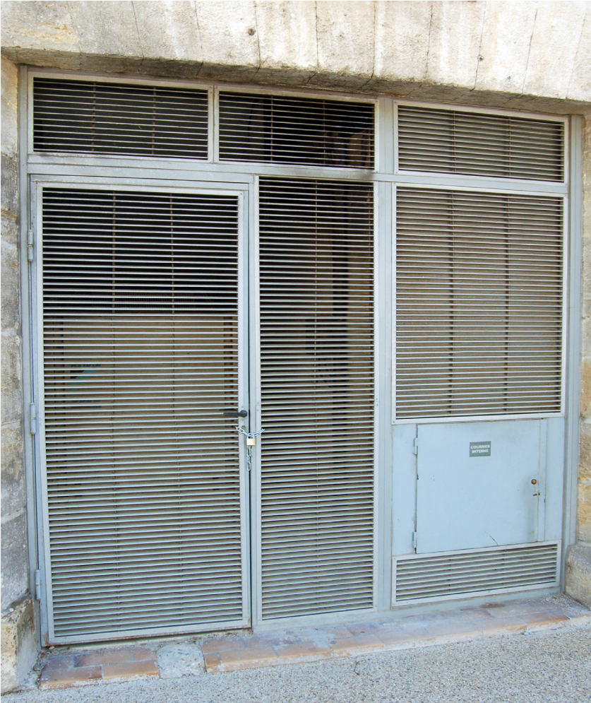
Exemple de locaux techniques intégrés dans un porche existant
